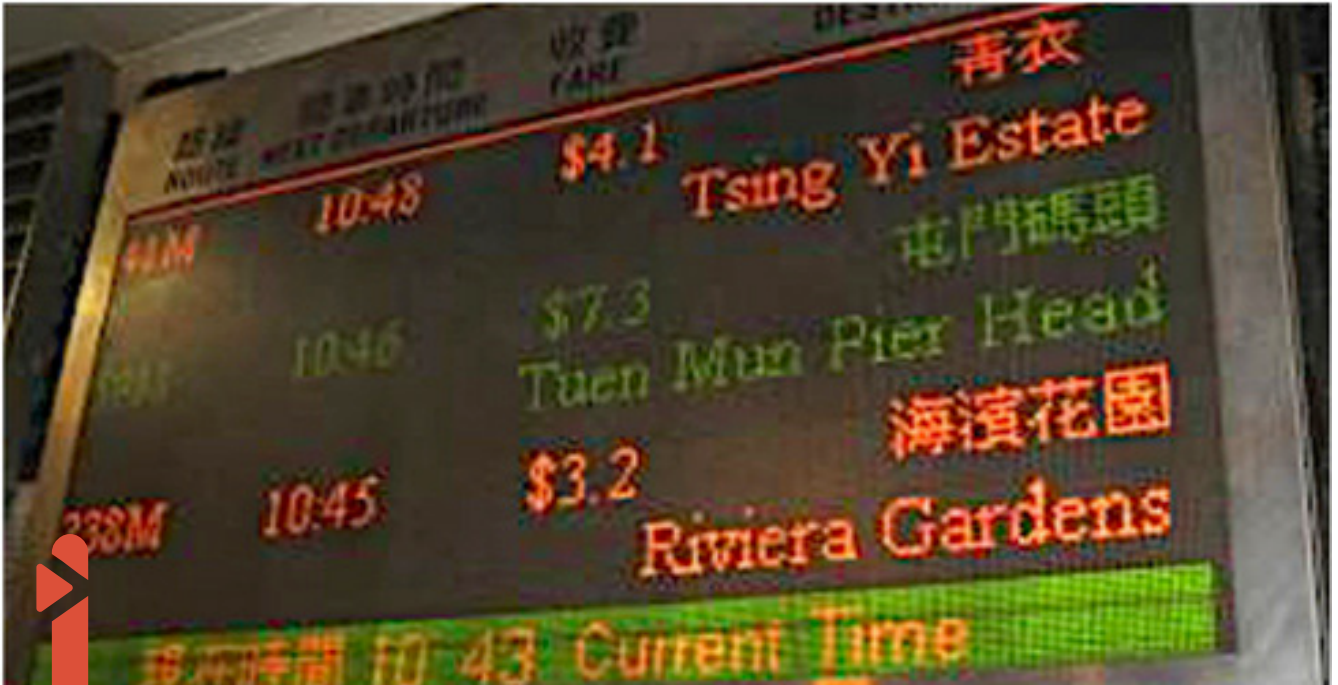
LED display for Kowloon Motor Bus stop 為九龍巴士有限公司車站安裝LED 顯示屏
